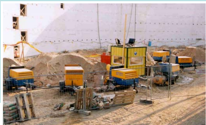
Großbaustelle mit UELZENER ESTROMAT Estrichmaschinen
