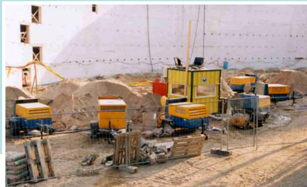
Gros chantier avec les pompes à chape ESTROMAT de UELZENER
