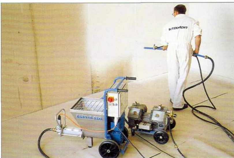
Verputzen mit Spritzgerät und Verlängerung
