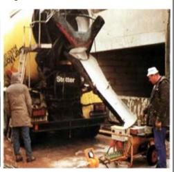
Durchlaufmischer ESTROMAT 404 und Klein in der Bauart - jedoch mit großer Robust, zuverlässig und wirtschaftlich kann eine Förderleistung von ca. 8 oder stoßfreiem Materialfluss können mehr als 100 m Förderweite erreicht werden.
