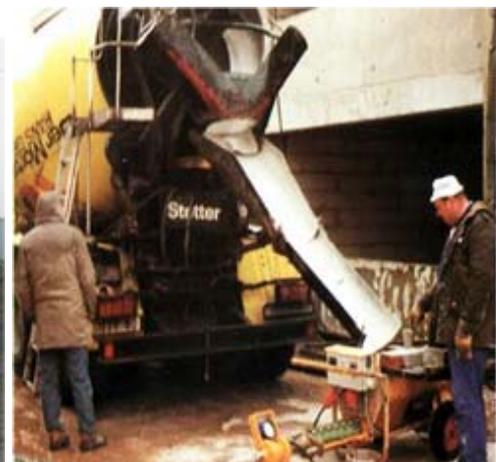
Robust, zuverlässig und wirtschaftlich fördert der PUTZKNECHT S 30-UE356 Fliessestrich direkt aus dem Fahr-mischer bis sieben Stockwerke mit Förderleistung bis 7 m<sup>3</sup>/h. Bei völlig stoßfreiem Materialfluss können mehr als 100 m Förderweite erreicht werden.
